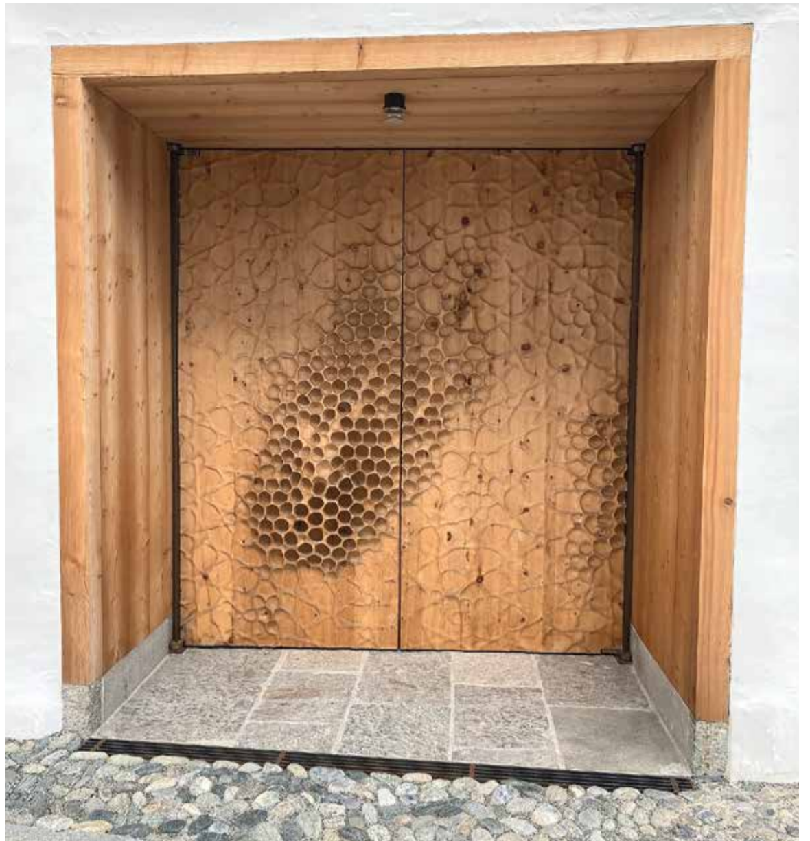
Oben: Bienenfleiss mit CNC in Arvenholz gefräst: strassenseitiger Eingang zum Auditorium im Museum Susch. BILD MICHAEL MEUTER, ZÜRICH
